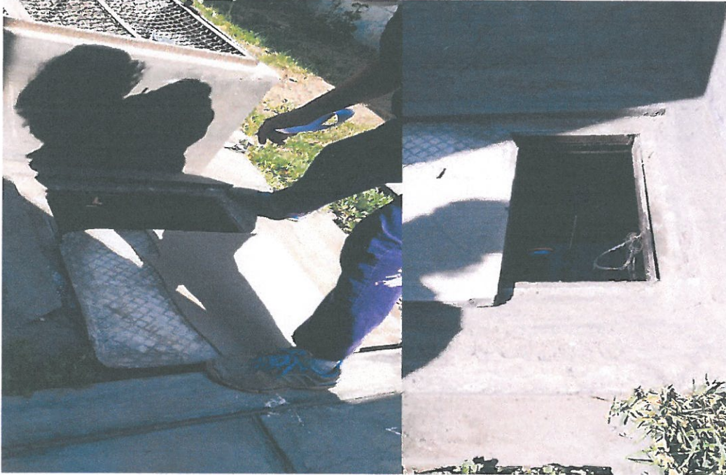
Imagen 9: Cisternas enterradas, alimentador por sectores.
