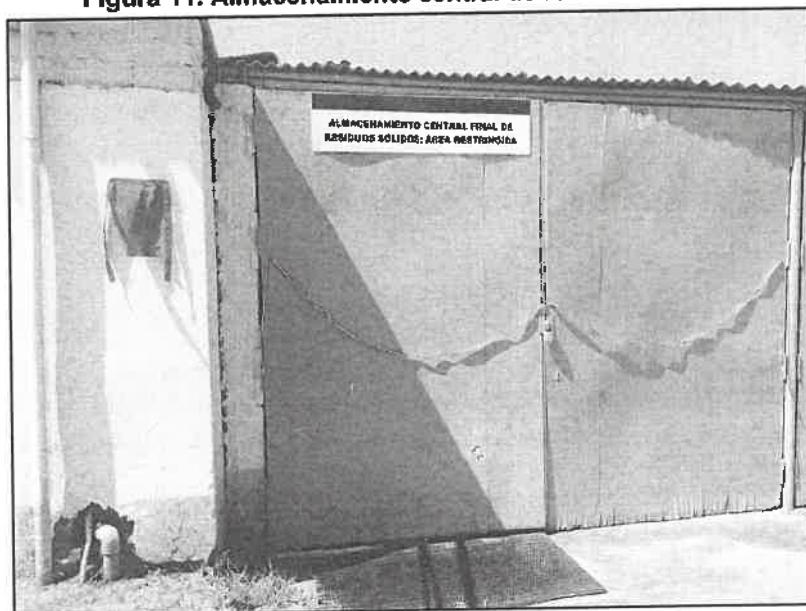
Figura 11. Almacenamiento central de residuos – CRÑ
