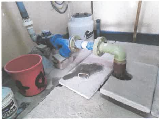
Bomba de agua del pozo tubular sin base
