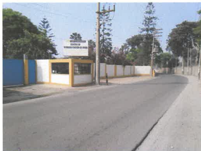
Puerta de ingreso y cerco perimétrico sin viga de amarre
