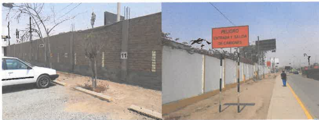
Cerco perimétrico sin viga de amarre colindante a la Av. Nicolás de Ayllon
