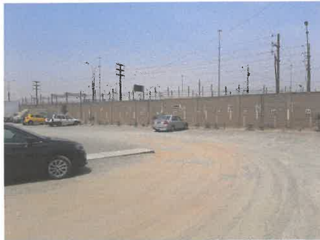
Cerco perimétrico sin viga de amarre colindante a la Av. La Cultura
