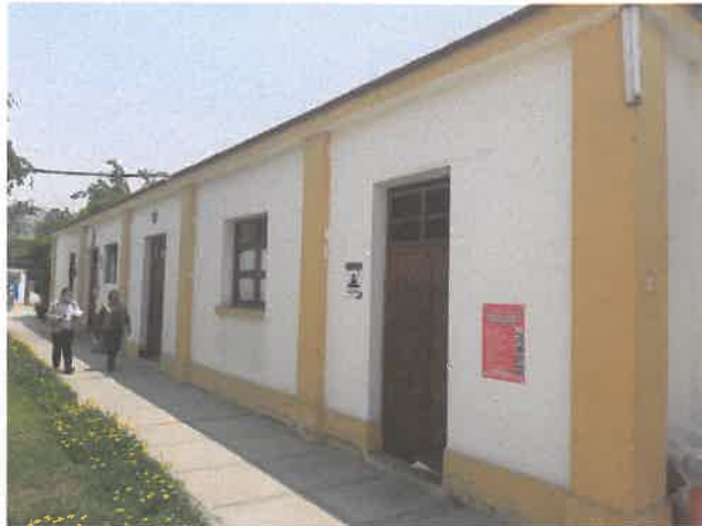
Ambientes construidos en 1944.
