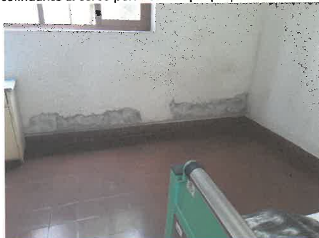
Vista de afloramiento de salitre en uno de los ambientes colindantes a área verde
