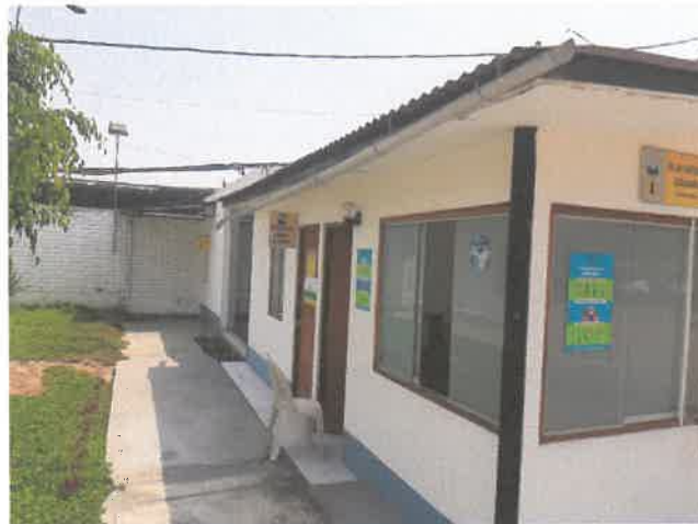
Ambientes construidos con drywall
