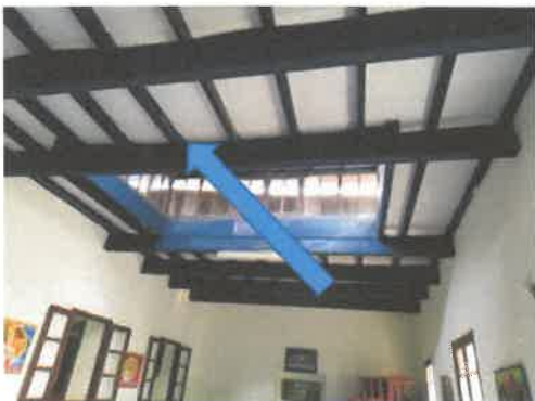
Vigas de techo bandeadas
