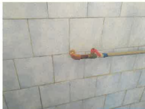
Tuberías, conexiones y llaves de control de agua así como cerámica requiere mantenimiento correctivo
