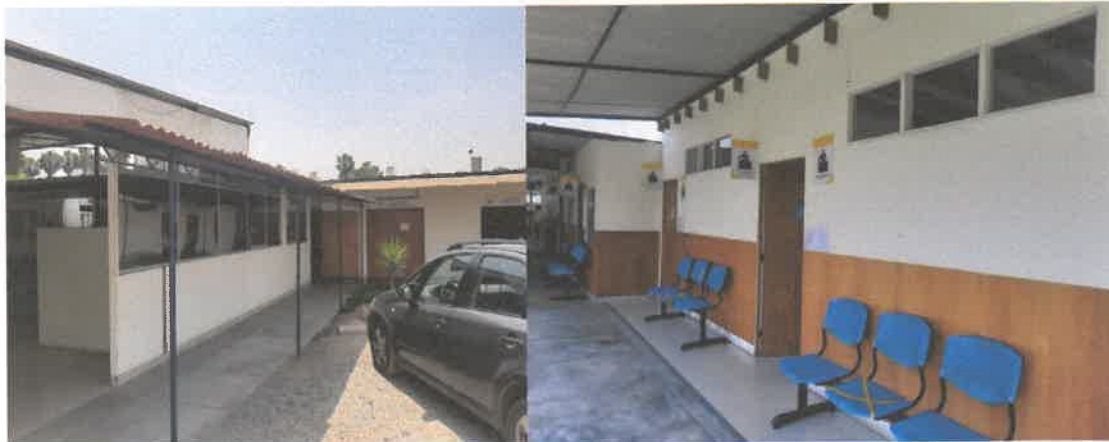
Ambientes administrativos construidos con drywall
