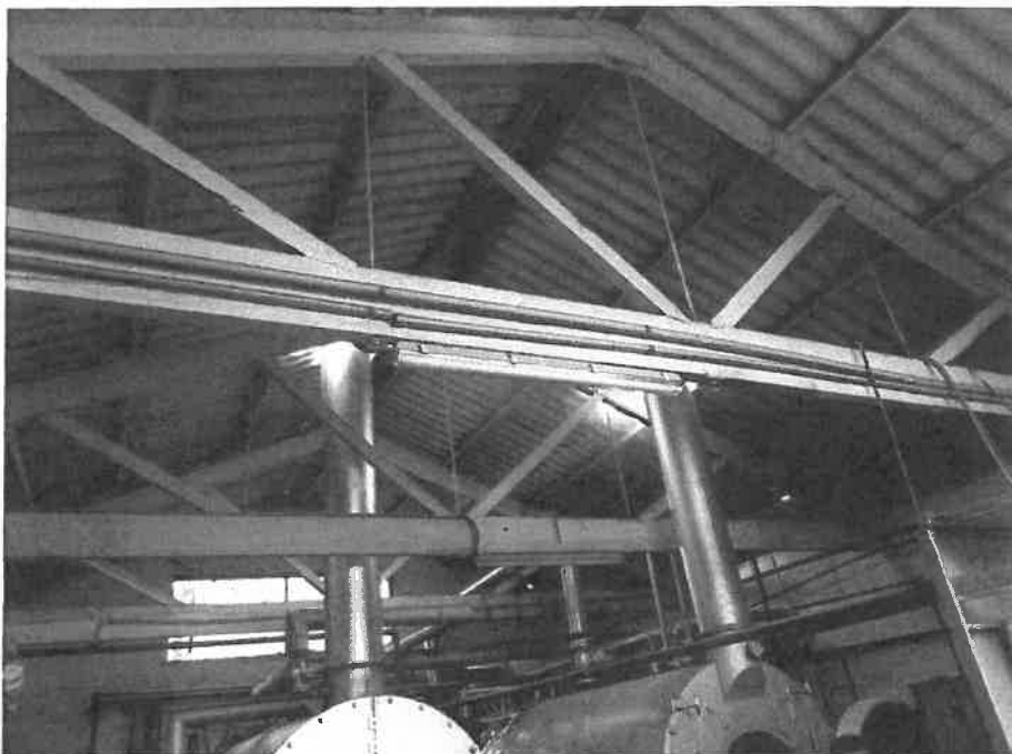
Foto N° 01 : Vista del techo de lavandería antes de la intervención
