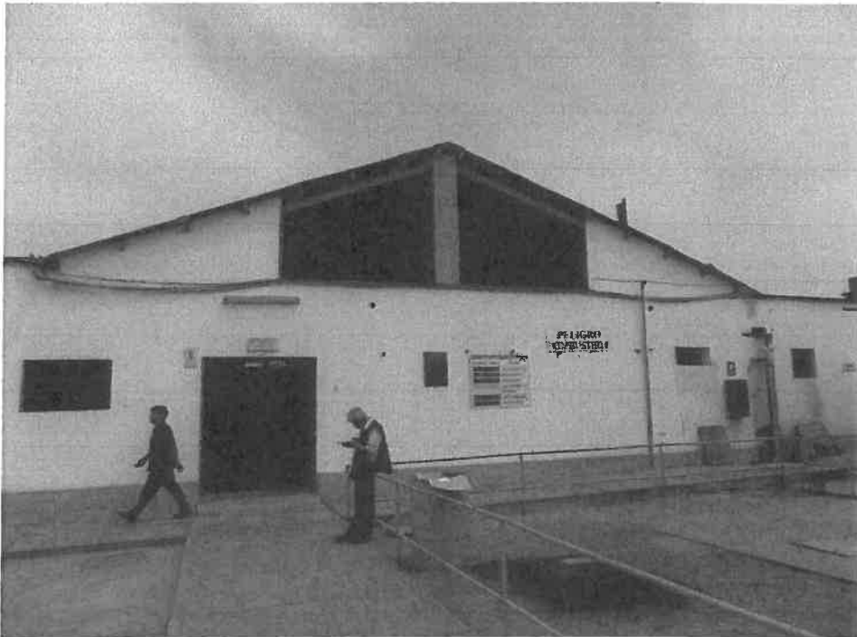
Foto N° 05 : Vista de la fachada externa de la Lavandería antes de la intervención.
