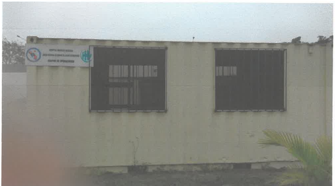
Centro de Operaciones
