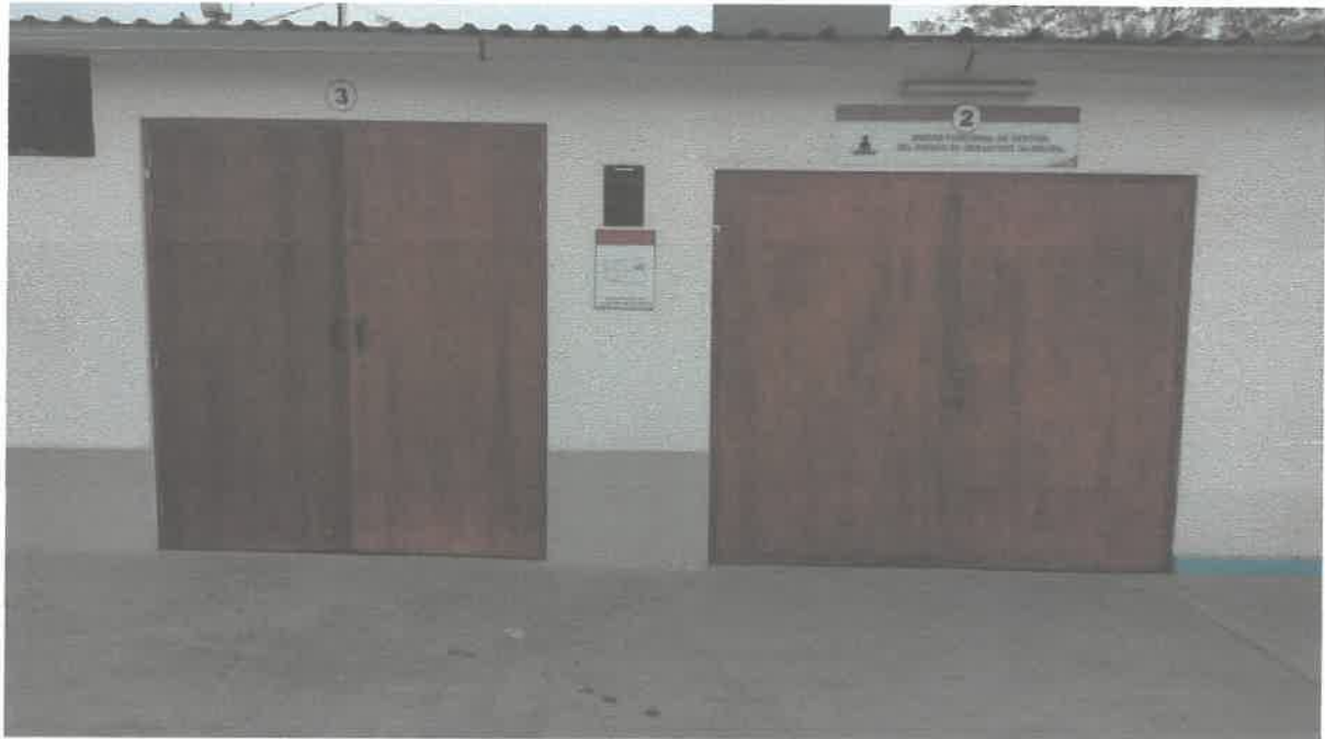
Almacén De Unidad Funcional de Gestión del Riesgo de Desastres
