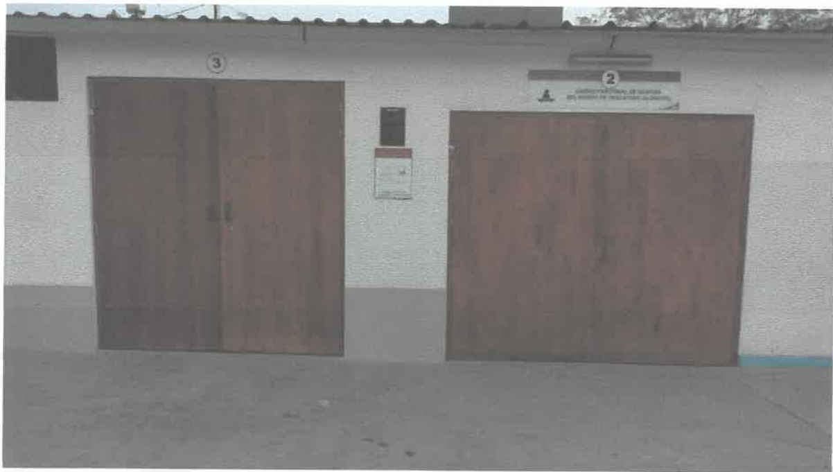
Almacén De Unidad Funcional de Gestión del Riesgo de Desastres
