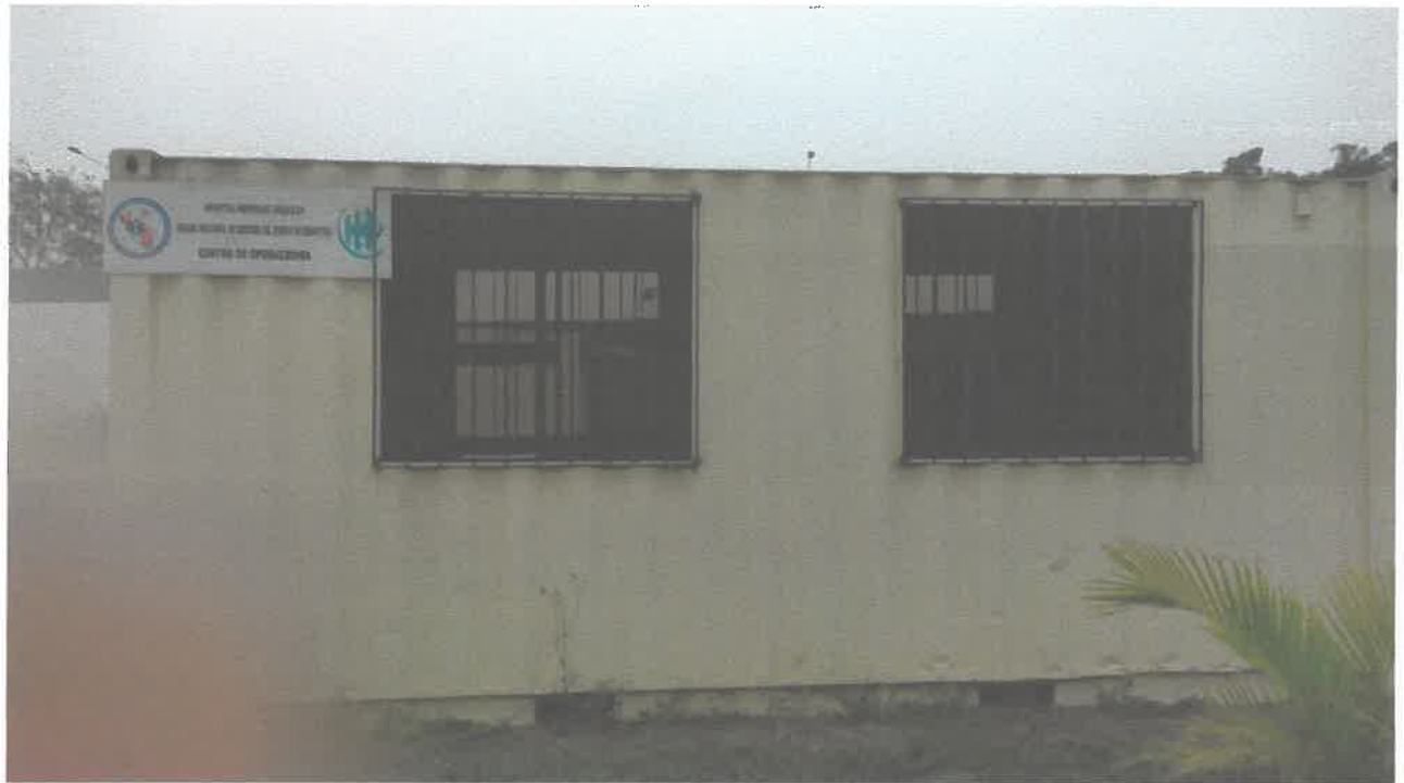
Centro de Operaciones
