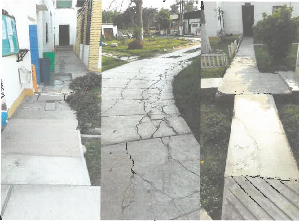
Vista de las veredas deterioradas en CR Ñana
