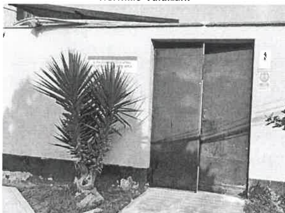
Figura 9. Almacenamiento central de residuos – Hospital Hermilio Valdizán.
