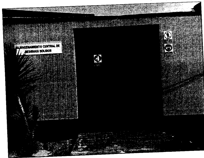
Figura 5. Almacenamiento central de residuos sólidos del Hospital Hermilio Valdizán
