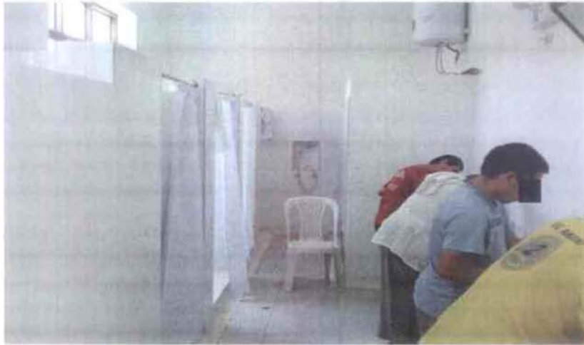
Acondicionamiento de Servicios higiénicos sector 5 varones
